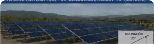
SISTEMA FIJO EN TERRENO
